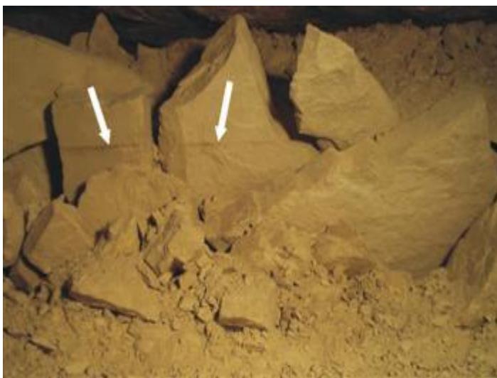
Poziomy ślad zastoiska wodnego w kopalni 795
